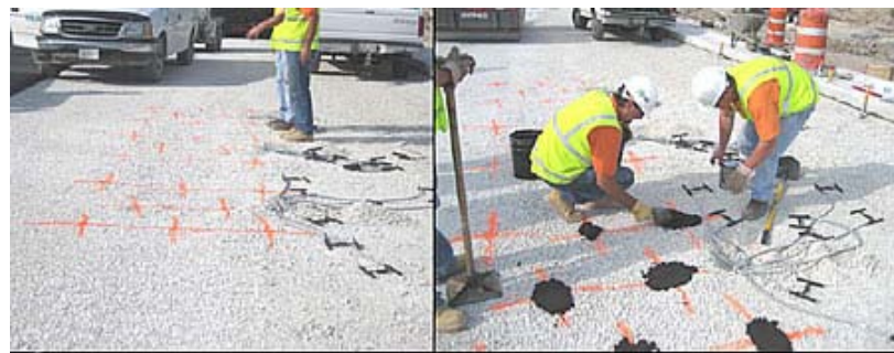
MARCADO Y COLOCACIÓN DE STRAINGAUGES
