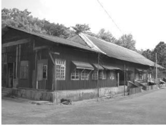
Edificación de 50 años en madera, sin dañar
